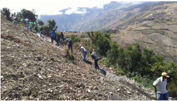
ハイチの方々が作業している様子
