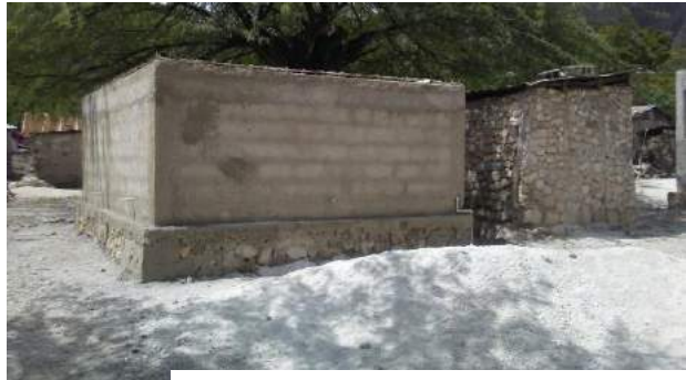
完成した給水施設
